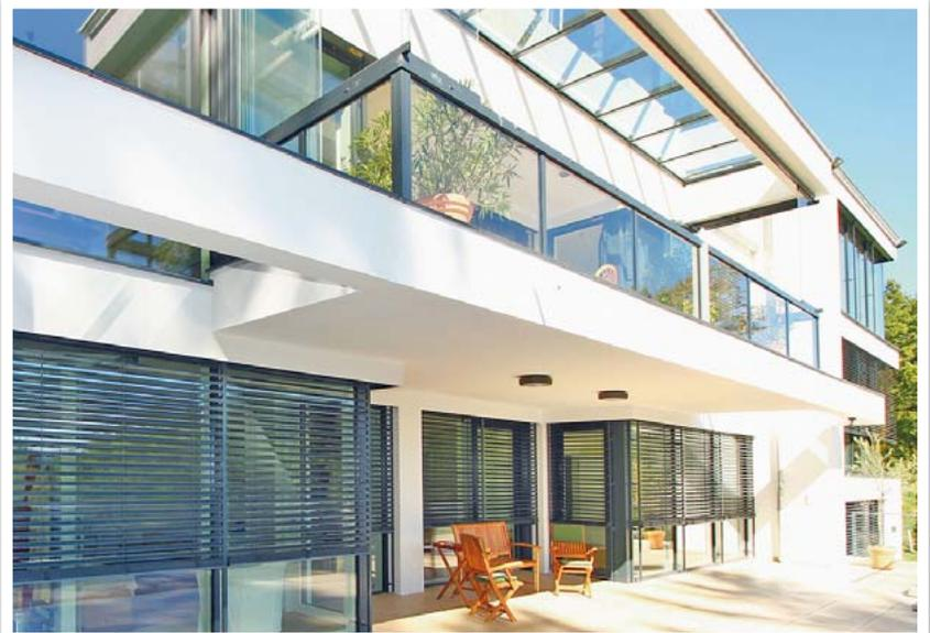
Spezielle Sonnenschutzgläser reduzieren im Sommer die Sonneneinstrahlung und verringern so das Aufheizen des Gebäudes, indem die Strahlen der Sonne dabei reflektiert oder absorbiert werden, ohne dass sie den Raum verdunkeln.
