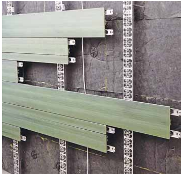
Die Paneele werden an dem patentierten Unterkonstruktionssystem befestigt. Foto: djd
