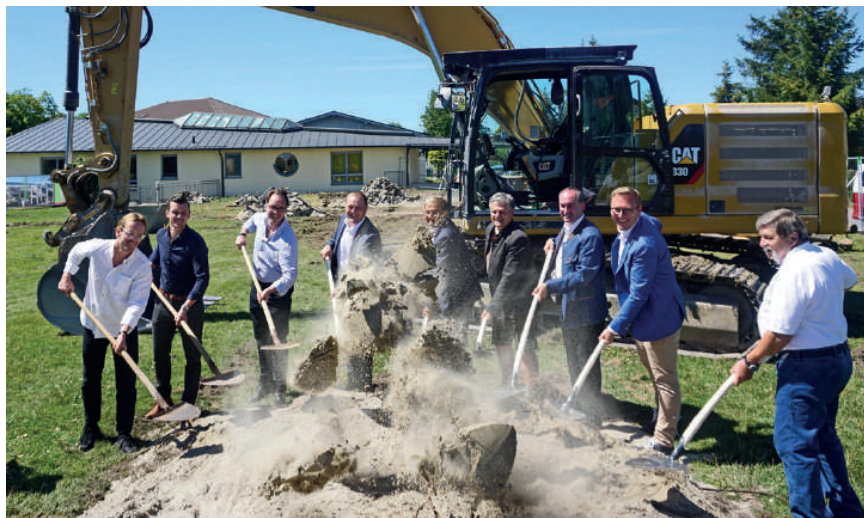
Mit dem symbolischen Spatenstich startete der Bau fürs Kinderhaus. FOTO: Gemeinde Alling
