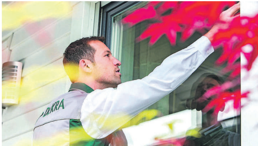
DEKRA Sachverständige prüfen auch den Zustand der Fenster.
