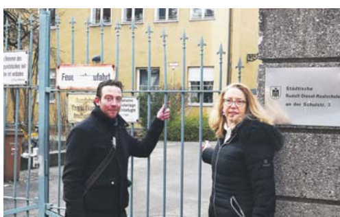
Schimmelbefall und marode Bausubstanz – Leo Agerer und Sabine Nasko fordern Neubau.
