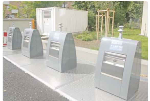
Das gibt es in München erst an ganz wenigen Stellen: unter die Oberfläche versenkte Wertstoffcontainer. FOTO: job
