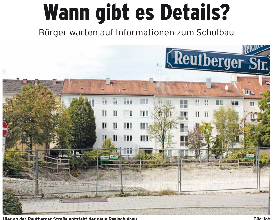
Hier an der Reutberger Straße entsteht der neue Realschulbau. Bild: job
