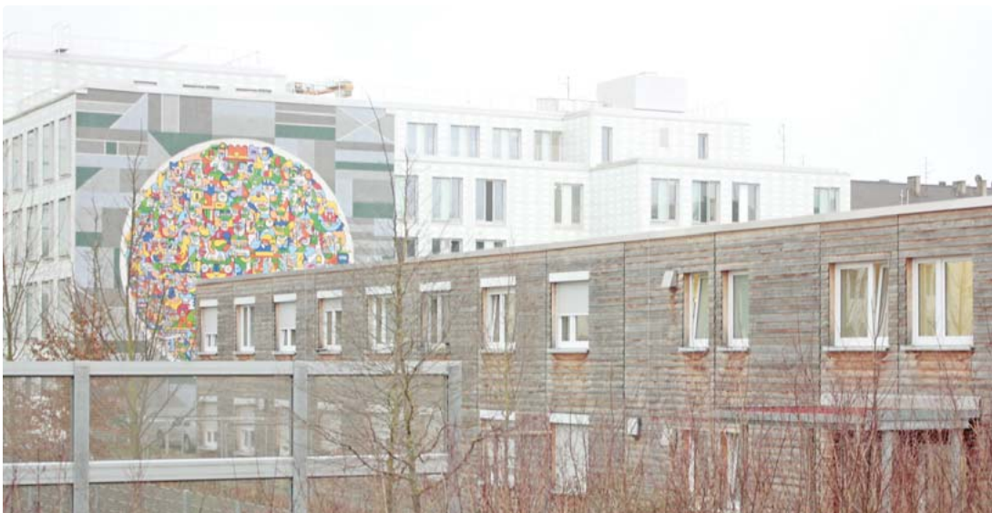
Zwischen Plinganserschule, Sozialbürgerhaus (2016 brachten Armin Kiss-Istok und Johannes Brechter ihr kreisrundes Fassadenbild „We Are All One“ hier an, Hintergrund) und Bahn liegt die Gemeinschaftsunterkunft. An ihrer Stelle entsteht einmal das Mehrgenerationenhaus. Bild: job
