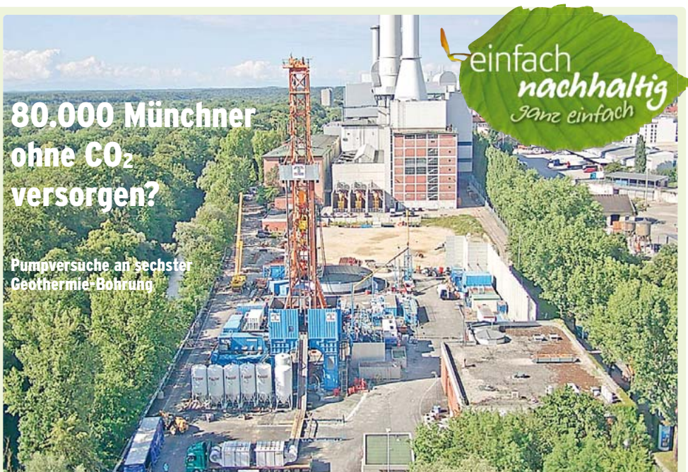
Die Geothermie-Bohrung am Heizkraftwerk Süd.
