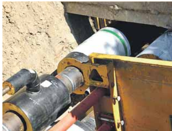
Die Verlegung ist schwierig, weil viele Sparten zusammenkommen. An die Hausanschlüsse für die Fernwärme ist von Anfang an gedacht. Foto: us
