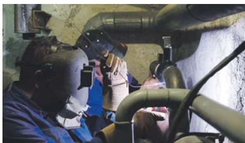
Der Fernwärmenetz wird fit für die Ökowärme gemacht. Gleichzeitig bauen die SWM ihre Fernkälte aus, um individuelle Klimaanlagen zu ersetzen. Foto: SWM/Vauel
