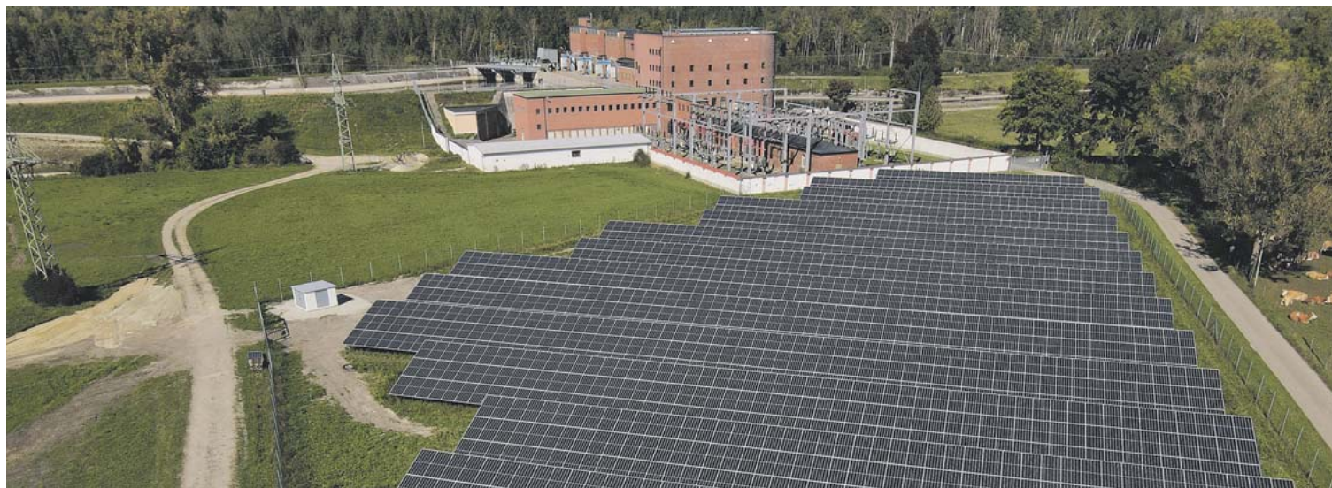
Rund um die Uppenborn-Wasserkraftwerke zwischen Moosburg und Landshut fangen die SWM zusätzlich die Kraft der Sonne ein: 5,6 Hektar groß ist der Photovoltaik-Park, der aus 8.262 Solarmodulen besteht. Die Drohnenaufnahme zeigt einen Ausschnitt der Anlage. Foto: SWM/ Klaus Kuhn
