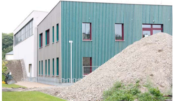
Turnhalle und Verwaltungsgebäude der Waldorfschule auf dem früheren Fürstenrieder Volksfestplatz wurden jüngst fertiggestellt. Bild: job
