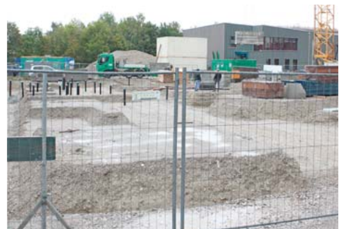
Letztes Bauvorhaben der Waldorfschule: Das Gebäude direkt an dere Züricher Straße, in dem das Gymnasium unterkommen wird. Bild: job
