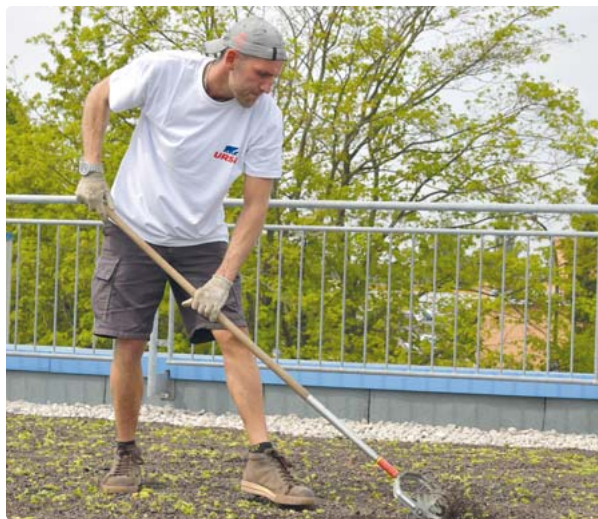
Wer sein Dach bepflanzen lässt, kann Energiekosten sparen. Denn Grönpflanzen wirken als natürliche Dämmung und Klimaanlage. Bei der Ausführung als Umkehrdach mit einer Dämmung aus Extruderschaumstoff hält das Flachdach beeindruckend lange. Foto: Ursa/txn
