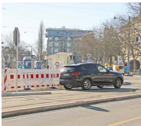
Die Straßenbauarbeiten am Romanplatz dauern voraussichtlich noch bis Herbst. Bild: sb
