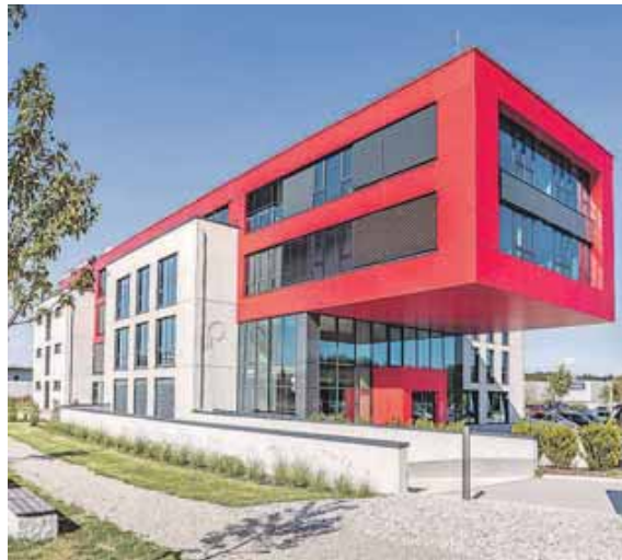
Hier findet man slimpuls in Gilching: im working & living House, Gewerbepark Süd. Foto: slimpuls
