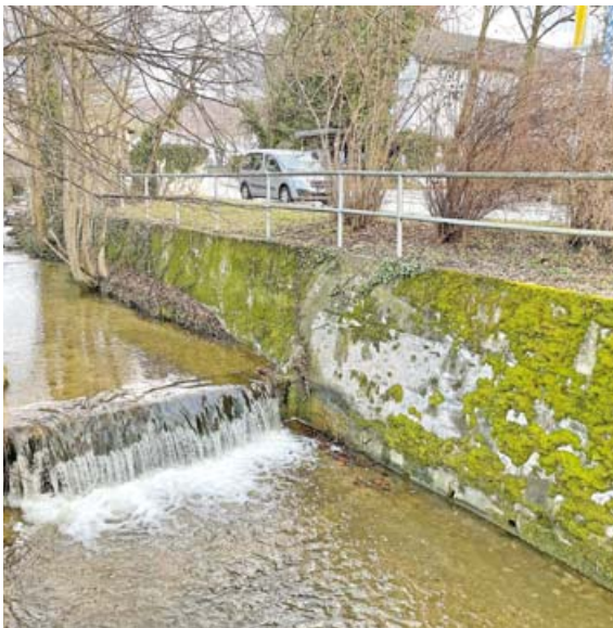
Die Uferbefestigung des Kienbachs soll saniert werden. FOTO: pst
