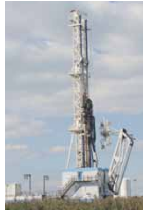
Ein Bohrturm (hier in Freiam) wird für die 16-monatige Phase der Probebohrungen benötigt. Foto: pst
