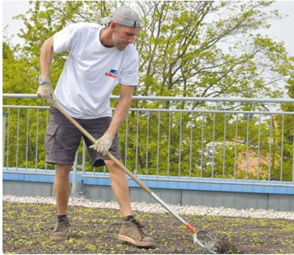
Wer sein Dach bepflanzten lässt, kann Energiekosten sparen. Denn Grönpflanzen wirken als natürliche Dämmung und Klimaanlage. Bei der Ausführung als Umkehrdach mit einer Dämmung aus Extruderschaumstoff hält das Flachdach beeindruckend lange. Foto: Ursa/txn
