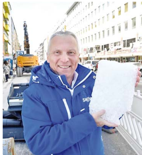
Für die Cool City 2.0: Helge-Uve Braun, Technischer Geschäftsführer der SWM, an der Fernkälte-Baustelle Schwanthalerstraße. Hier entsteht der Anschluss an den künftigen Fernkälte-Standort in Sendling. Bild: SWM
