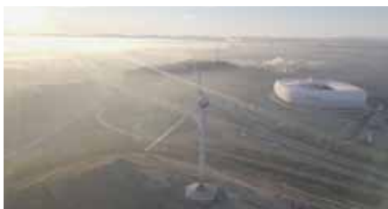
Weithin sichtbare Symbole für den Münchner Klimaschutz: die Windkraftanlagen im Münchner Norden. Foto: SWM/Rintisch
