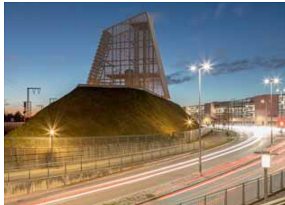
Mit der anspruchsvollen Energiezentrale Freiham haben die SWM auch architektonisch ein Zeichen gesetzt. Die Geothermieanlage versorgt von hier aus den Münchner Westen mit Ökowärme aus der Tiefe. Foto: SWM/Sageder
