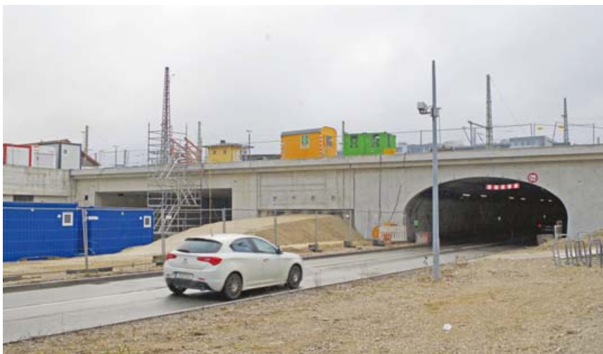
Am nördlichen Ausgang der Laimer Röhre ist bereits der Zugang zum neuen Tunnel, der Umweltverbundröhre, zu erkennen. FOTO: Beatrix Köber
