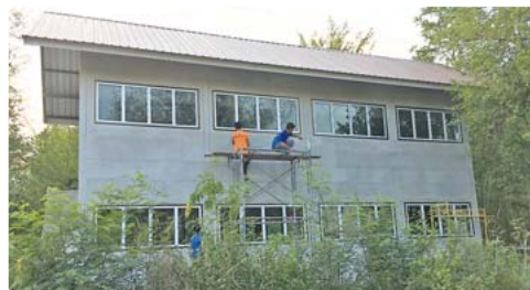
Die Unterkunft für Meditierende am Tempel Ban Nong Aek in Thailand soll mit Hilfe der Spende fertiggestellt werden. Bild: Wijiit Battemdee
