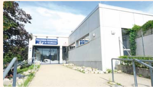
Das Hallenbad Germering ist im Jahr 1972 in Betrieb gegangen. Bild: Isc
