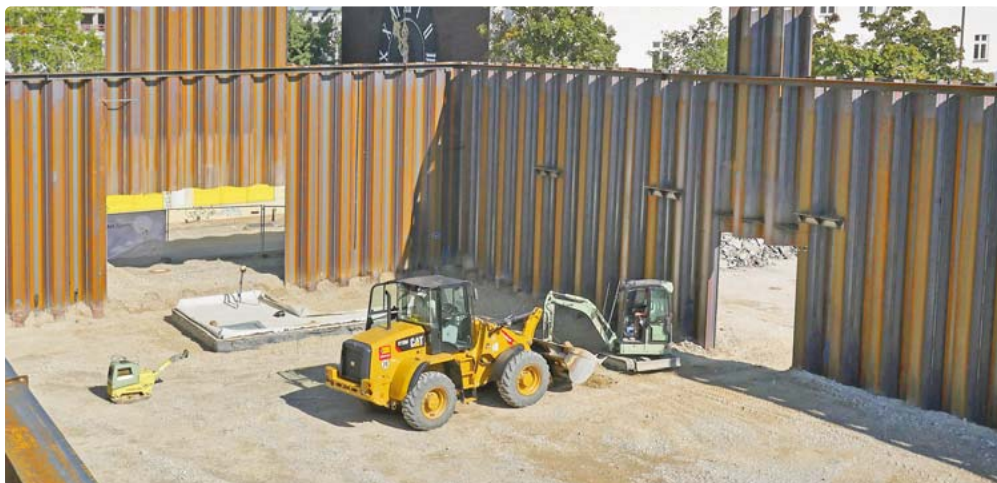
Aktuell laufen die Bauarbeiten für die neue Spielstätte des „schwere reiter“ im Kreativquartier. Die Eröffnung ist für Spätsommer 2021 geplant. Bild: MGH / Alexandra Wenzel
