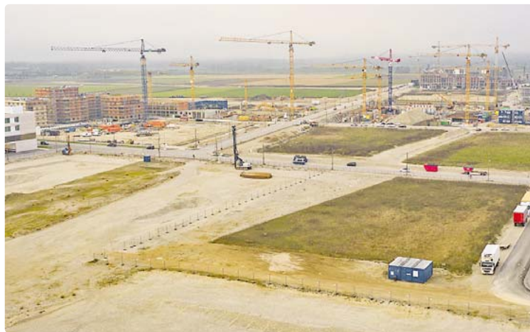
Auf dieser Mammutbaustelle wird in einigen Jahren ein neues Wohnviertel entstanden sein. Bild: MGS/Jonas Nefzger
