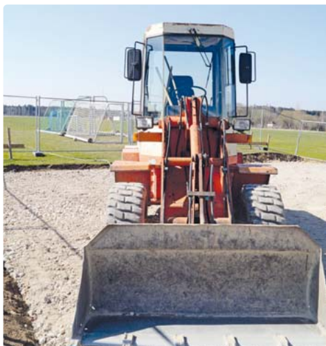
Der Bagger steht bereit. Der Bau kann beginnen.
