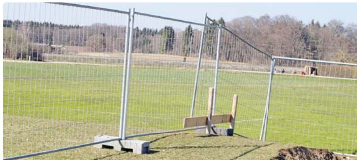
Die Bauzäune sind bereits aufgestellt.
