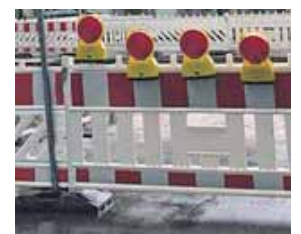
In der Preysingstraße laufen Bauarbeiten. Foto: hw
