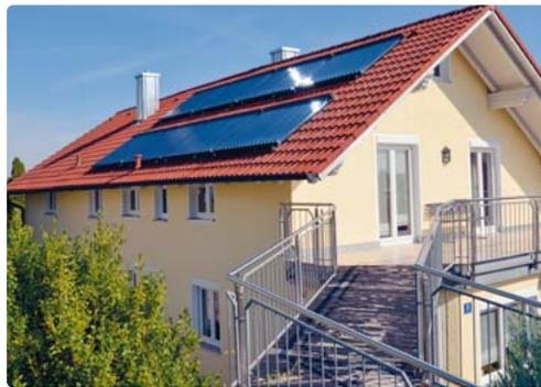
Mit Vakuumröhrenkollektoren lässt sich das ganze Jahr Energie in Form von Wärme beziehen. Hauptsächlich werden sie im Bereich der Warmwasserbereitung, bei der Hausbeheizung sowie in gewerblichen Bereichen eingesetzt. Foto: HLC/Solarbayer GmbH
