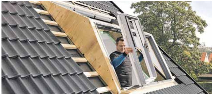
Fenster sollten nach 20 bis 30 Jahren ausgetauscht werden – Witterung und UV-Strahlen nagen am Material. Grafik: Velux
