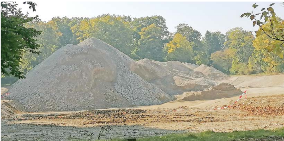
Der Altbau der ehemaligen Gehörlosenschule ist inzwischen abgetragen. Auf dem Areal soll der Bildungscampus Am Westpark entstehen. Bild: job
