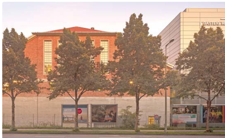
Die Halle E (links) neben der neuen Isarphilharmonie (rechts). Die Halle entstand im Zuge der Erweiterung des E-Werkes an der Isartalstraße in den Jahren 1926-28. Während des Zweiten Weltkrieges wurde sie schwer beschädigt, aber bis 1950 wieder aufgebaut. Bild: HGEsch/gmp Architekten
