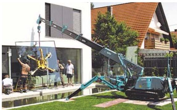
Scheibentausch mit einem Roflag Miniraupenkran bei großen Scheiben. FOTO: Roflag
