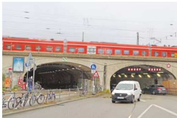
Die Laimer Röhre verbindet die Stadtbezirke Laim und Neuhausen miteinander. Aufgrund der laufenden Bauarbeiten am S-Bahnhof kommt es innerhalb des Tunnels immer wieder zu Konflikten zwischen Radfahrern und Fußgängern.
