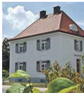
Das historische Bahnbedienstetenhaus am S-Bahnhof Unterföhring, bekannt als »Zindlerhaus«, erstrahlt nach Sanierung in neuem Glanz.
