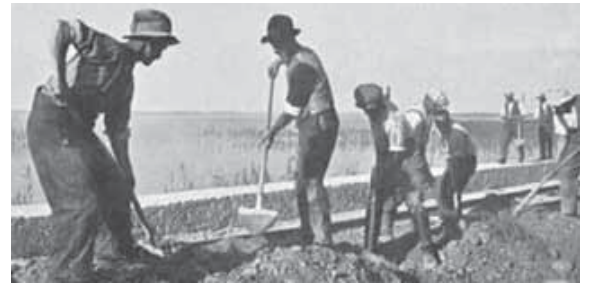
An vielen Stellen wurde zeitgleich an der Fertigstellung der Autobahn zwischen München und Salzburg gearbeitet. Vieles wurde noch händisch erledigt. Foto: Archiv Linner
