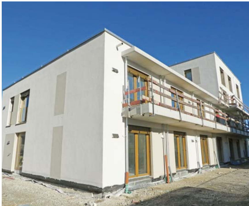
Noch nicht ganz fertig: Blick auf den Südflügel des Hospiz und Frauenhauses.
