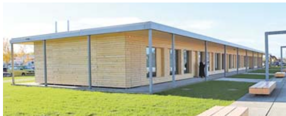
Neues Gebäude für Ganztagsbetreuung des GMI: architektonisch gelungener Pavillon in Holzständerbauweise. FOTO: GMI Indersdorf
