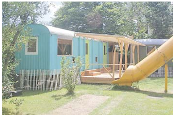
Die Waldkindergarten der Familie Ritter in Krailling ist fertiggestellt. Im April können 20 „Kleine Ritter“ hier naturnah betreut werden. FOTO: Waldkindergarten Krailling
