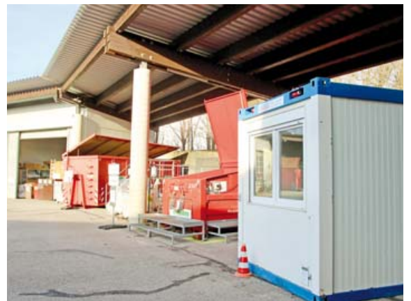
Container als Übergangslösung für einen Teil der Belegschaft auf dem Planegger Wertstoffhof, bis ein neuer Aufenthaltsbereich gebaut ist. FOTO: us
