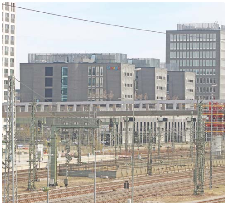
Die Fuß- und Radwegbrücke am Arnulfpark soll bis Ende 2020 fertig gestellt sein. Bild: sb
