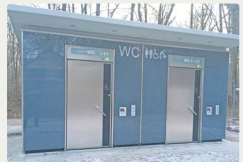
Ist schon in Betrieb: die Toilettenanlage im Sendlinger Wald. Bild: Nagel
