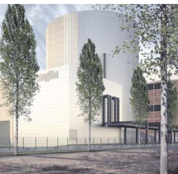
Der Energiestandort Süd wird ab 2021 klimafreundliche Fernwärme und Fernkälte produzieren.
