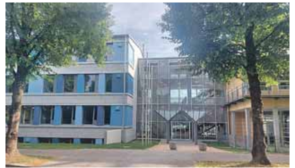
Rund 29 Millionen Euro hat die Sanierung der Grundschule an der Bahnhofstraße gekostet. Foto: bas
