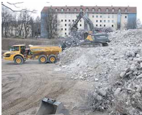
Das waren mal die Kreuzhofbrücken: Schuttberge werden neben der Autobahn aufgetürmt. Im Hintergrund einer der Wohnblocks zwischen Cimbriestraße und Einhornallee.
