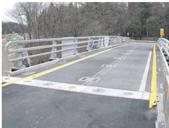
Eine der Ersatzbrücken, über die der Verkehr zur A 95 geleitet wird.
