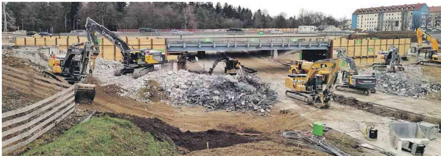
Blick auf die Baustelle der Kreuzhofbrücken. Bereits abgerissen ist die kleinere der beiden Brücken auf der Ostseite. Wer aus Richtung Garmisch kommend am Kreuzhof die A 95 verließ, überquerte über sie die Boschetsrieder Straße, ehe er auf die Fürstenrieder Straße Richtung Laim einschwenkte. Fotos: job
