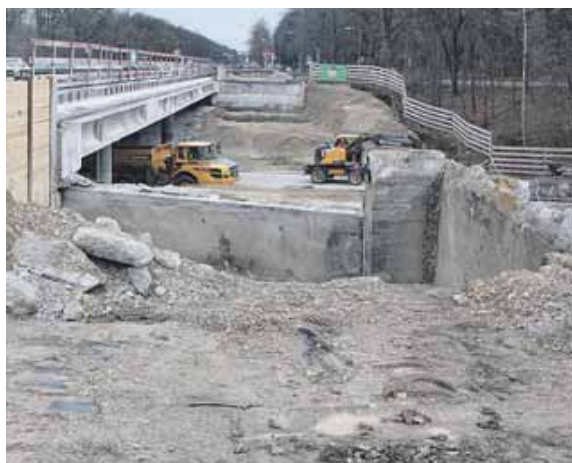
Auch der westliche Teil der Kreuzhofbrücke fehlt hier schon. Wer von der Boschetsrieder Straße kam und auf die A 95 Richtung Garmisch wollte, fuhr über sie zur Autobahnauffahrt.
