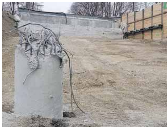
Hier stand die kleinere der beiden Brücken – einer der Pfeiler ist noch in Resten da.
