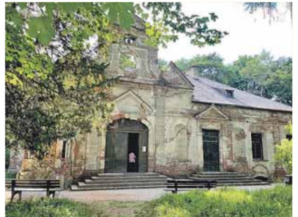
Die Magdalenenklause wurde als Ruine geplant. Sie ist gemauert und nur teilweise verputzt. Die Risse im Mauerwerk und der abbröckelnde Putz sind Stilelemente. Foto: bb
