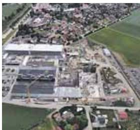
Große Baumaßnahmen laufen bei GEWO. Foto: GEWO
