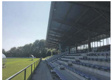
Bisher befinden sich die Umkleidekabinen unter der Tribüne.
