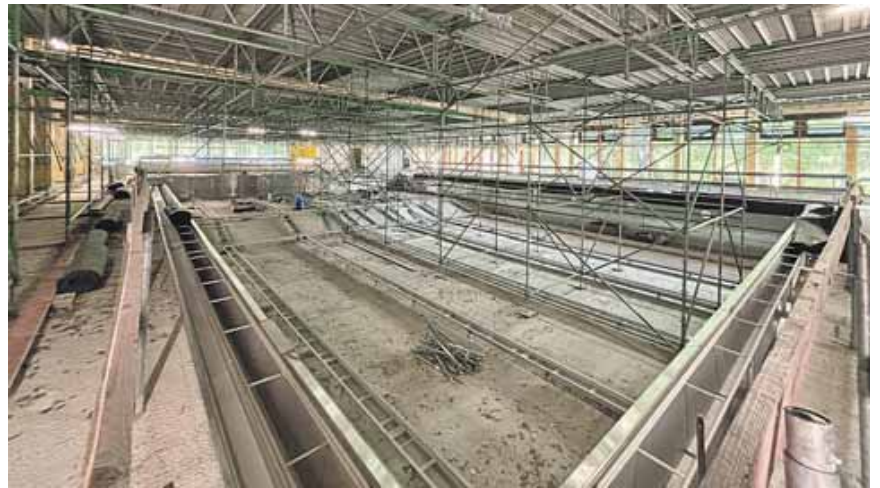
Noch ist die Schwimmhalle eine Baustelle. In eineinhalb Jahren soll sie fertig sein. F.: Ulrike Seiffert
