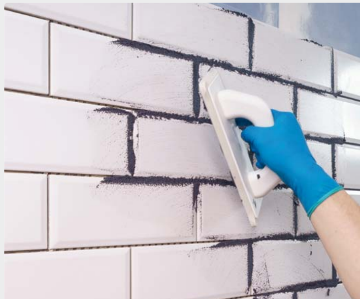
Feine Fugen: Mit den passenden Materialien lassen sich attraktive Fliesenflächen einfach selbst gestalten. Foto: djd/Knauf Bauprodukte/Philipp Kudella
