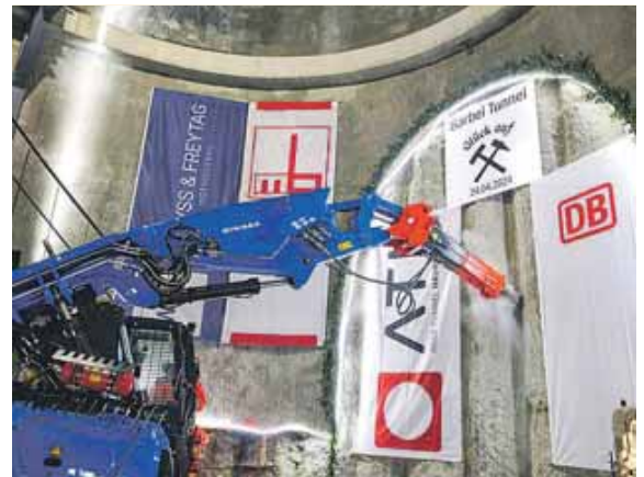
Das 55 m lange Rettungsbauwerk liegt in bis zu 34 Metern Tiefe an der Hackerbrücke. Foto: DB AG/panterra.tv
