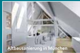
Altbausanierung in München
